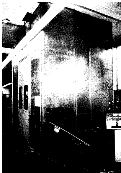
Bild 7 Materialauslauf an der Spezial-Kapselung
